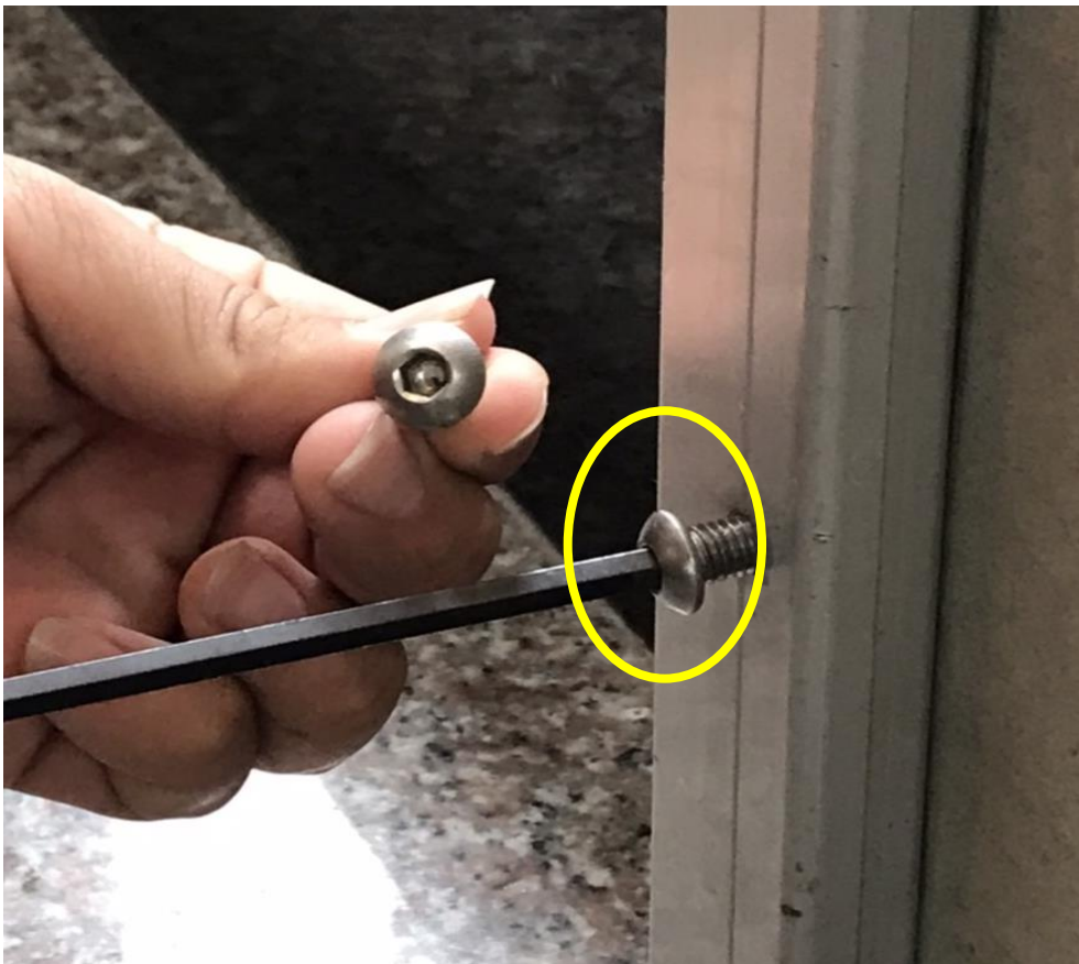
步驟五. 裝上側邊上、中、下螺絲後完成水閘門
