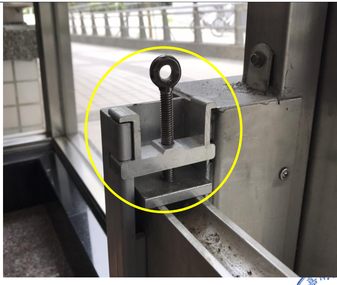
螺絲及螺帽、上方破緊閘門片
