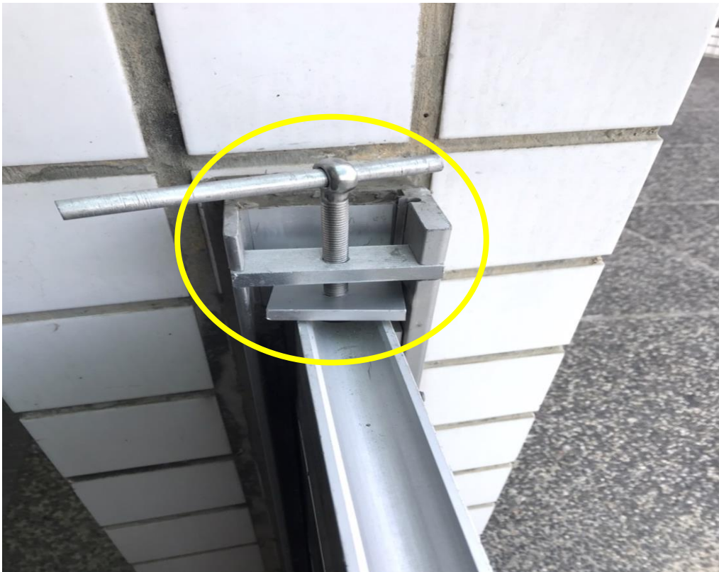
步驟八. 安裝上方迫緊閉門片(所有柱條)
