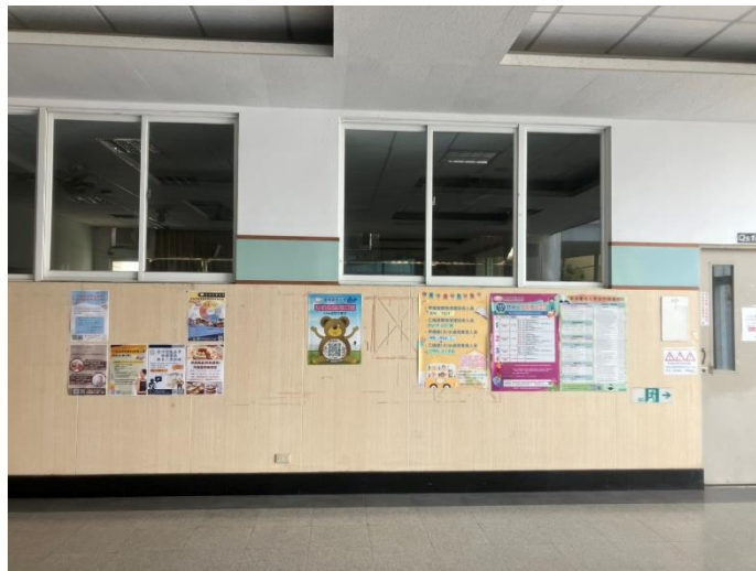
QS 棟資訊暨教學大樓
