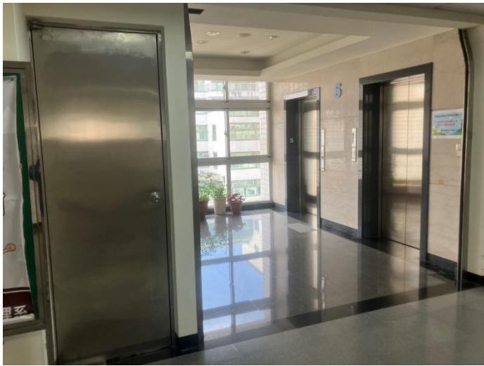
電梯鐵門殘膠已清除
