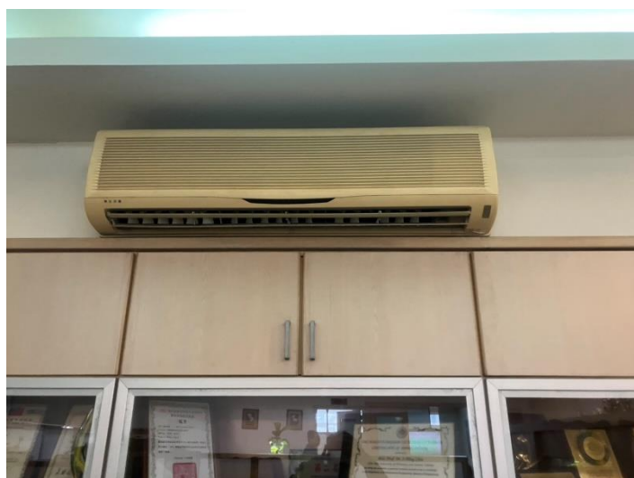
冷氣灰塵已清除
